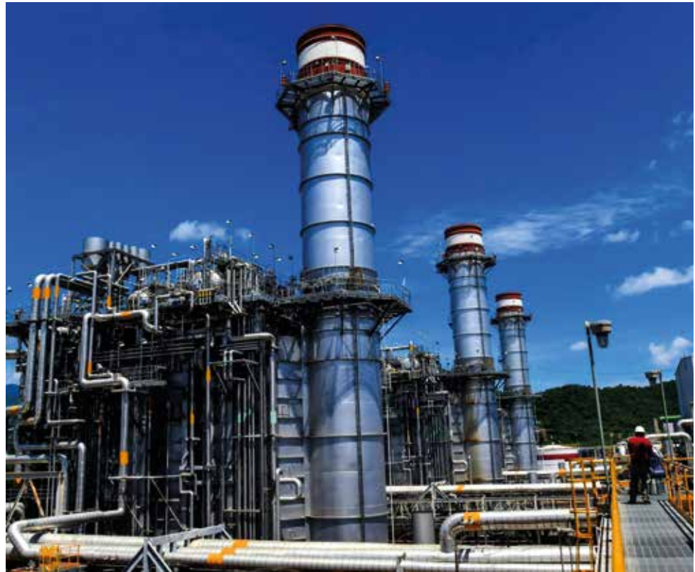
La compañía Tamazunchale Energía porque ésta fue adquirida por Iberdrola Generación México S.A. de C.V.
