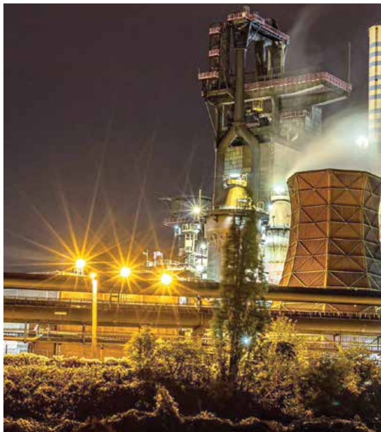
En América Latina, el 70 por ciento de la producción es mediante alto horno, y solo 30 por ciento en horno de arco eléctrico.
